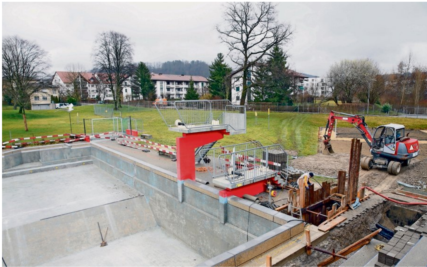
Noch ist das Freibad eine Baustelle. Und aufgrund einbetonierter Leitungen steht nun mehr Arbeit an als ursprünglich angenommen.
